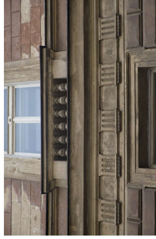
Fasáda v detailu
