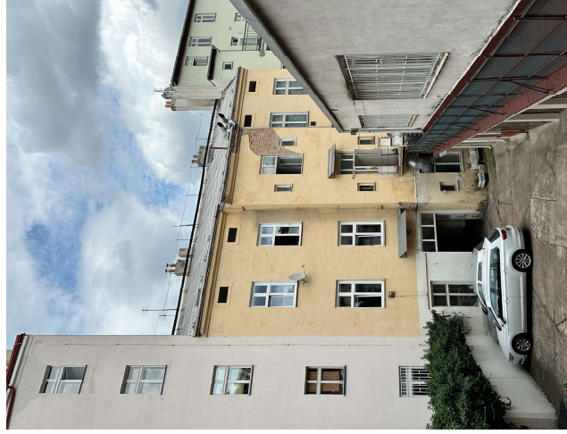
pohled na fasádu
