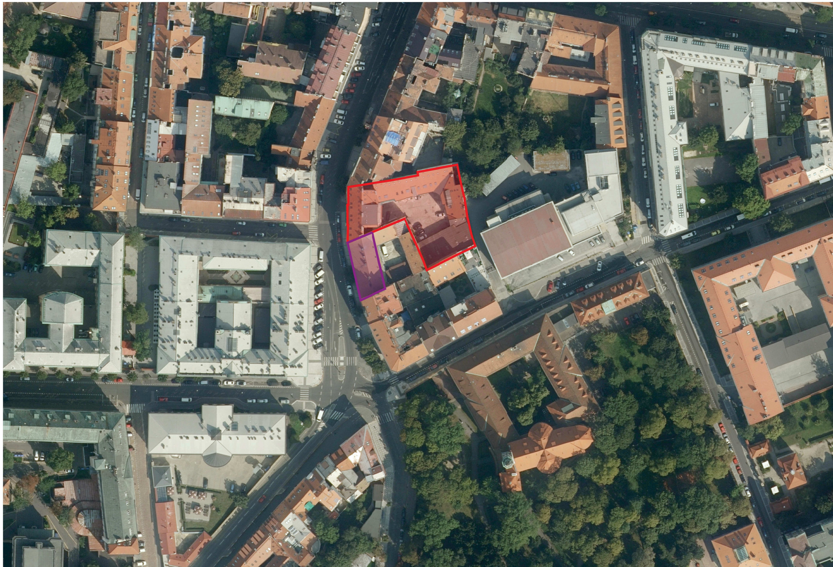
— Dvorní vestavba, Lípová 10 — Uliční nástavba, Lípová 8
